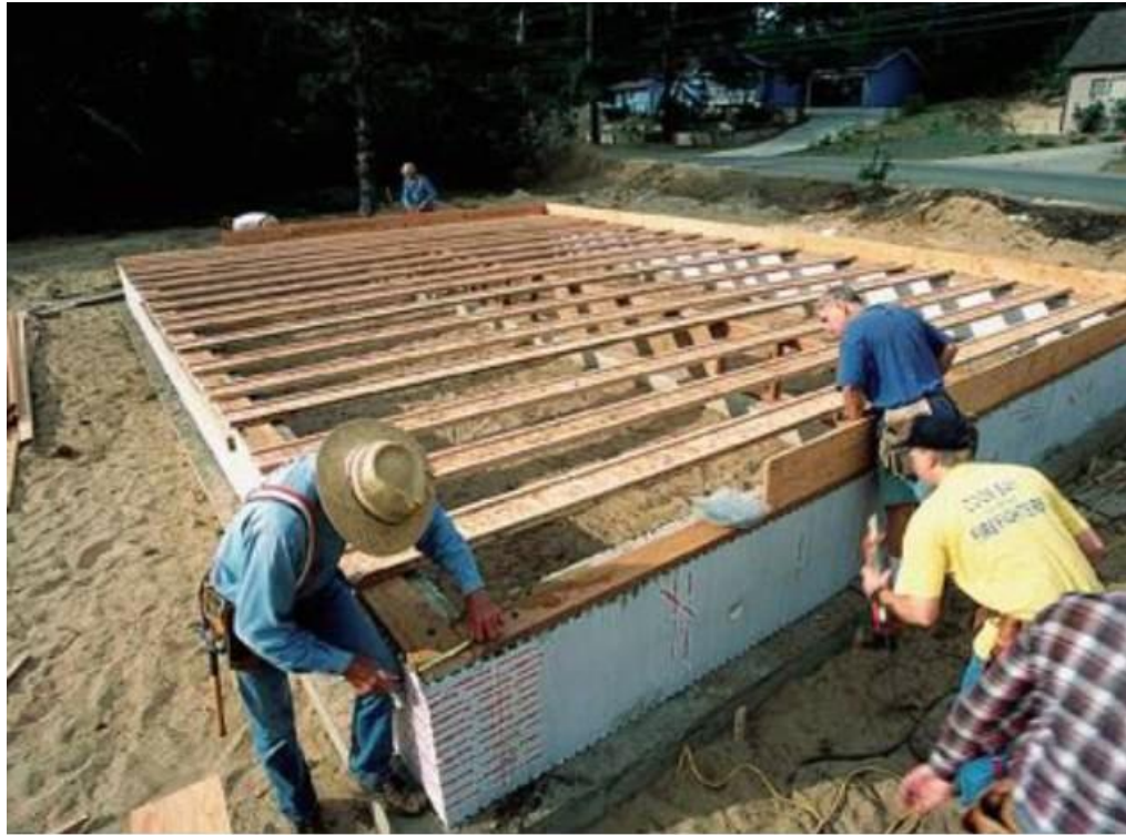
1-лаги легкие, прочные и унифицированные. Многие строители предпочитают использовать фабричные 1-лаги, нежели 2-дюймовые цельнодеревянные лаги.
