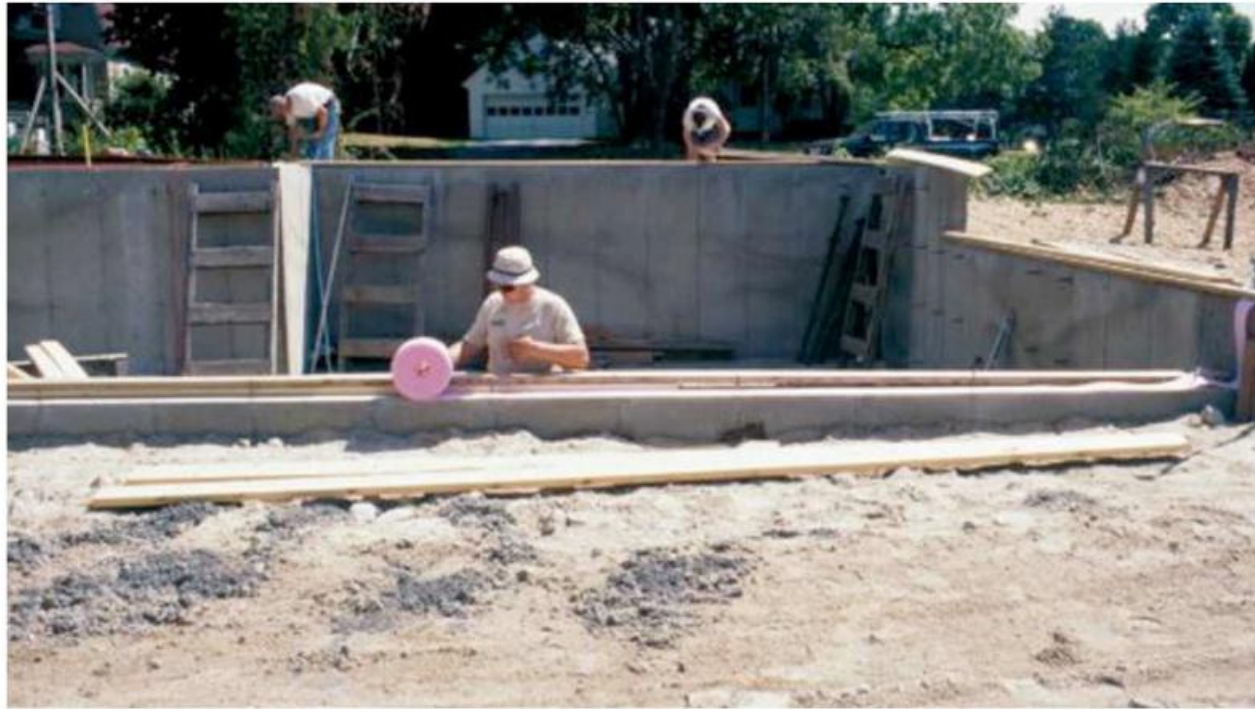
Используйте герметик (уплотнитель), который защитит Вас как от насекомых, так и сквозняков. Проложенный между опорным брусом и фундаментом, он образует упругий изоляционный слой, заполняя неровности, и создает надежный барьер между внутренним пространством и внешним. [Photo © Mike Guertin]
