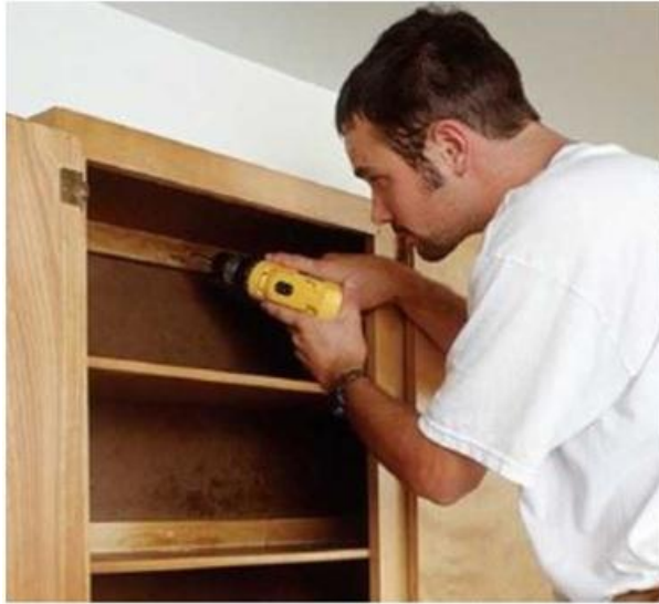
Установка встроенного шкафа.
