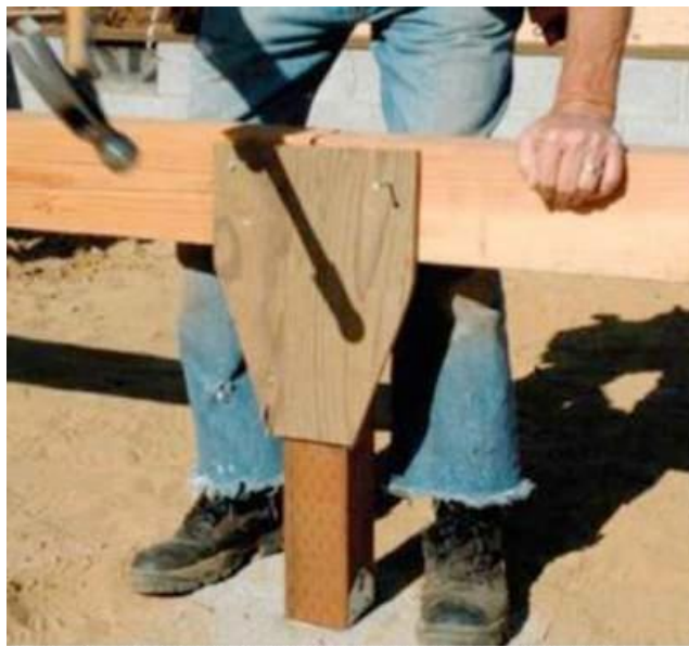
Стяжки или накладки из фанеры надежно скрепляют балки со столбами. [Photo by Don Charles Blom]
