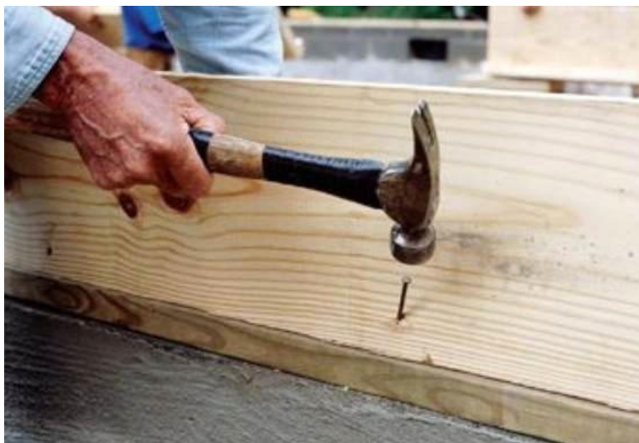
Установите внешние лаги. Наружная сторона внешней лаги (называемой также обвязочной лагой) должна быть заподлицо с внешней стороной опорного бруса. Прибейте лагу гвоздями 16d через каждые 16 дюймов, забивая их под углом.
